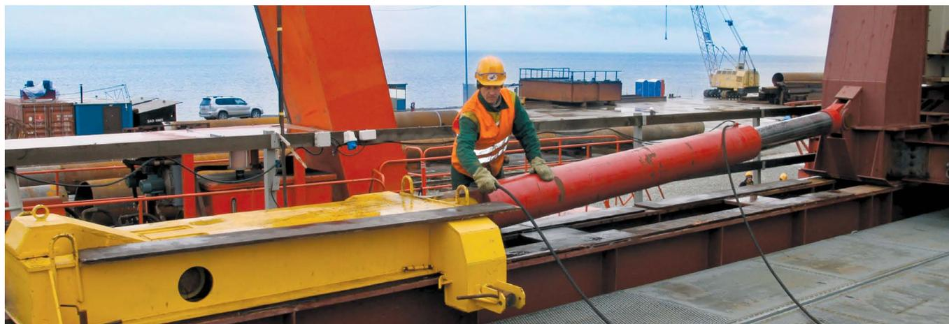
■ Толкающий комплекс, модель ТМК400Г2500 применен для продольной надвижки мостовых конструкций по металлическим балкам с дискретным упором за поперечные балки (накаточный путь) при строительстве низководного мостового перехода через Амурский залив к полуострову Де-Фриз, г. Владивосток.
